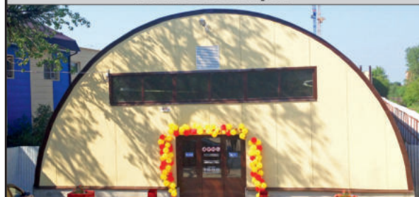
СКЛАДСКИЕ И ПРОИЗВОДСТВЕННЫЕ ПОМЕЩЕНИЯ
